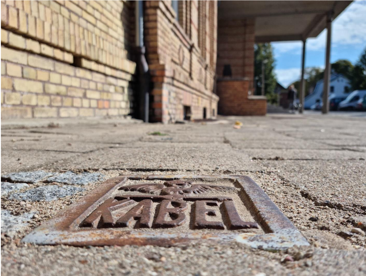
Ein Relikt aus vergangener Zeit: Ein gusseiserner Kabelstein der Staatseisenbahn am Demminer Bahnhof, welcher die Richtung des verlegten Kabels anzeigt.
