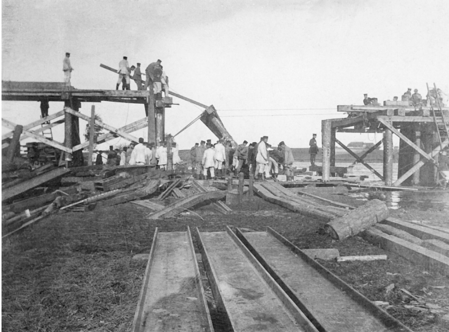
Die Aufnahme zeigt das Brückenbaukommando unter Oberleutnant Gumme beim Aufrichten eines Bockes.
